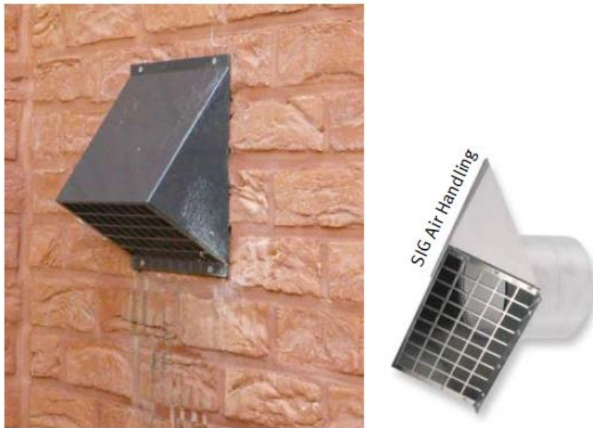
Figuur 32: Luchtinlaat voorzien van een grofmazig roostertje.
