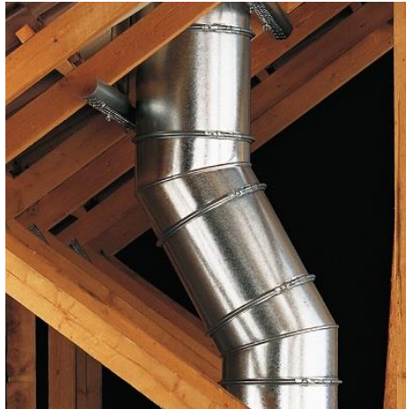
Figuur 1: Voorbeeld van afwijking (versleping) (bron: Poujoulat).
