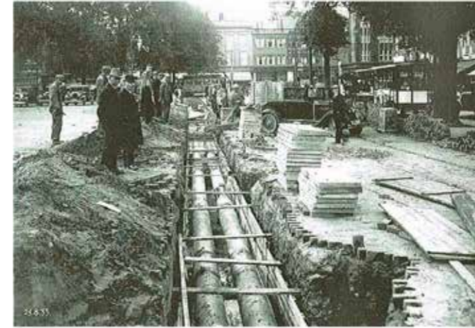
Aanleg van het eerste Nederlandse warmtenet in 1923 in Utrecht.
